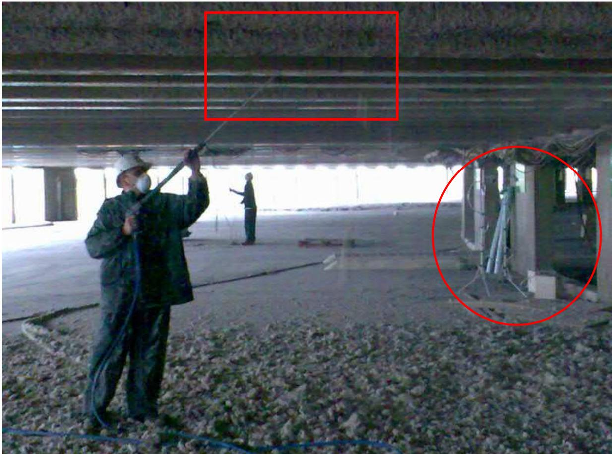
Figure 5 : Chantier de retrait du flocage dans un parking couvert. Encerclé en rouge, le dispositif de prélèvement avec une pompe et deux têtes en parallèles fixées sur pieds
